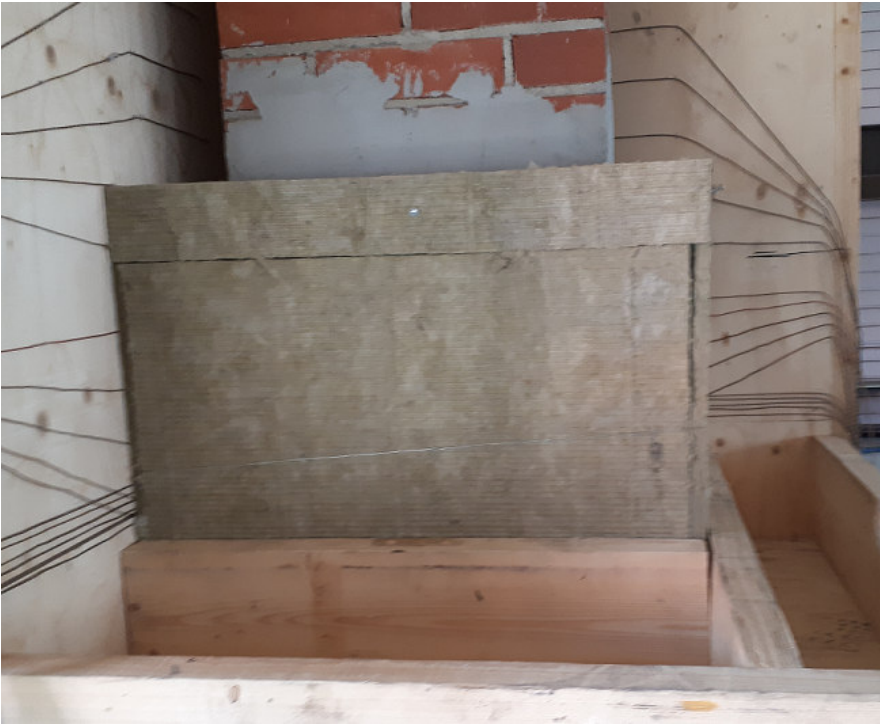
Kuva 1 Läpivientirakenne (ilman välipohjaeristettä)
