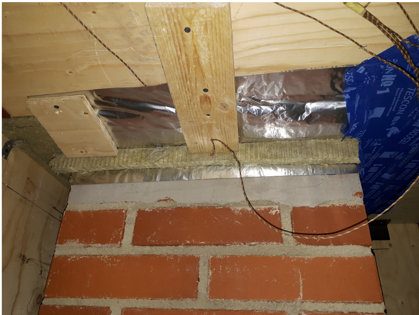
Kuva 5. Läpiviennin tiivistysteippien asennuksesta ja välipohjan alapinnan lämpötilamittauksesta.
