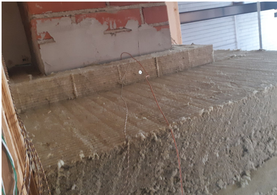
Kuva 2 Läpivientirakenne välipohjaeristeen kanssa testivalmiina.
